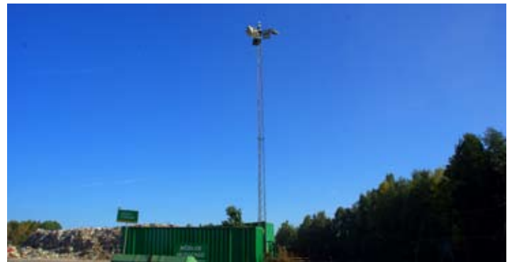
Här monterad under testet på återvinningsstationen.
